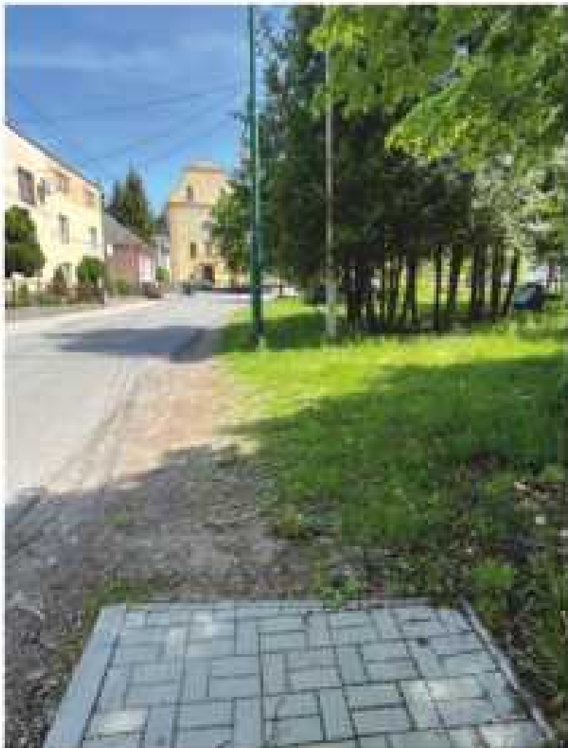
Nedokončený dláždený chodník pozdĺž komunikácie. Foto: M. Bilý
